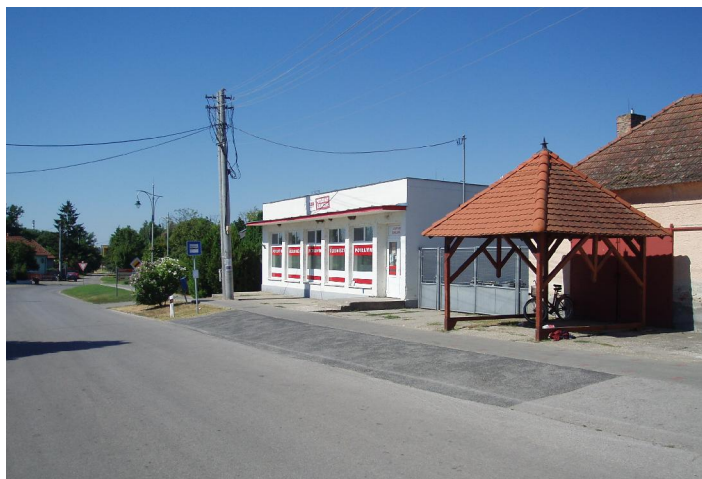
POTRAVINY, STARÁ ULICA
